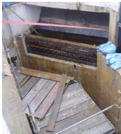
Budowa zamknięcia szandorowego
