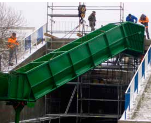
Montaż turbiny: montaż śruby Archimedesa pod płytą pomostu na uprzednio wykonanych elementach posadowienia
