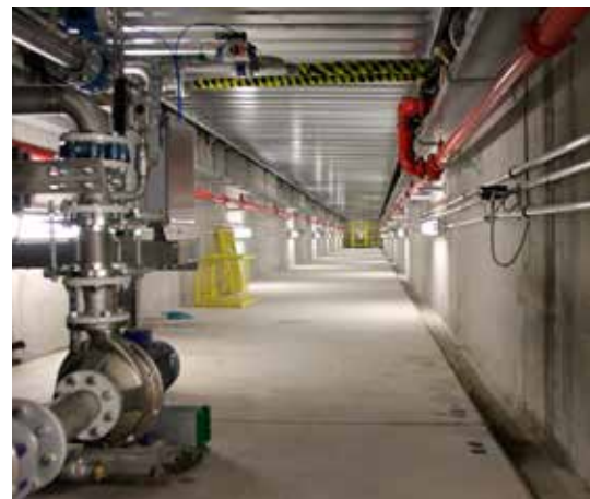
Tunel pod prasą formującą z wszechobecnymi instalacjami tryskaczowymi
