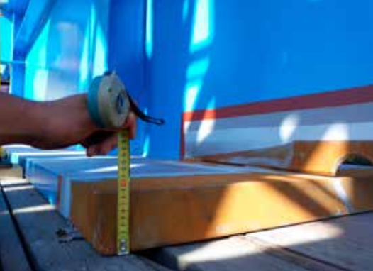
Pas dolny najdłuższego przęsła ma grubość – bagnetela - 9 cm
