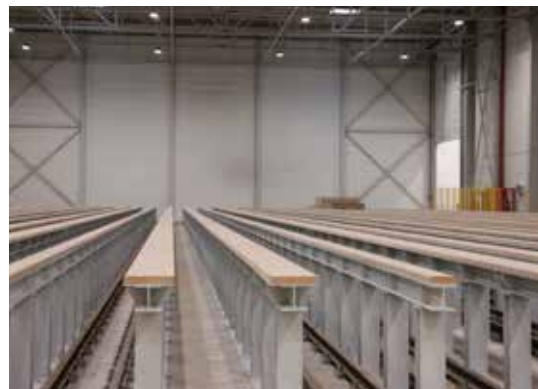
Zautomatyzowany magazyn płyty surowej w stocach do chłodzenia przed podaniem na linię szlifowania
