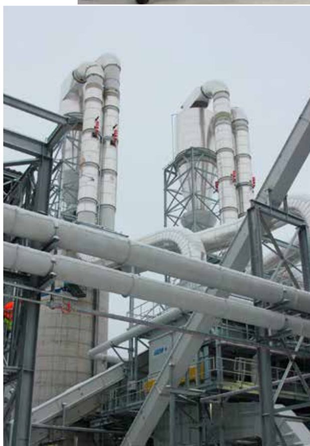
Początek linii formowania koberca ze zmieszanych ze spoiwem wiórów. Widoczne transportery wiórów drobnych i grubych oraz systemy odpylania
