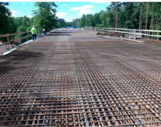
Na zbrojenie płyty pomostu estakady użyto 770 t stali
