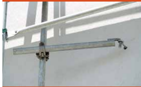
7a. Luźna i pod dużym kątem zamocowana kotwa
