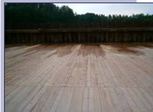
Gotowa drewniana obudowa poszuru
