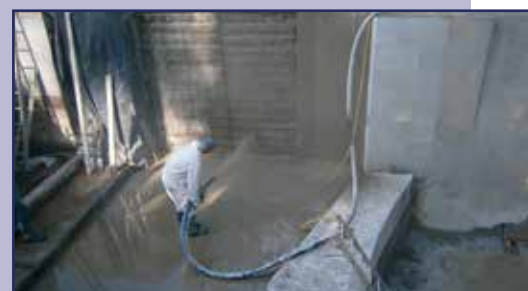
Wykonywanie torkretowania
