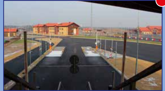
PRZEJŚCIE GRANICZNE W POŁOWCACH/2014-2015
