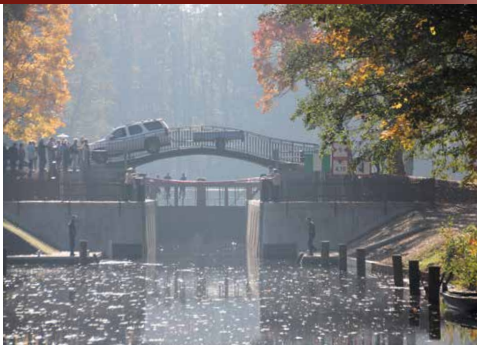
Wyremontowany został most nad śluzą. Wymieniono skorodowane i pognięte bariery – wszystko w uzgodnieniu z inwestorem i Wojewódzkim Konserwatorem Zabytków
