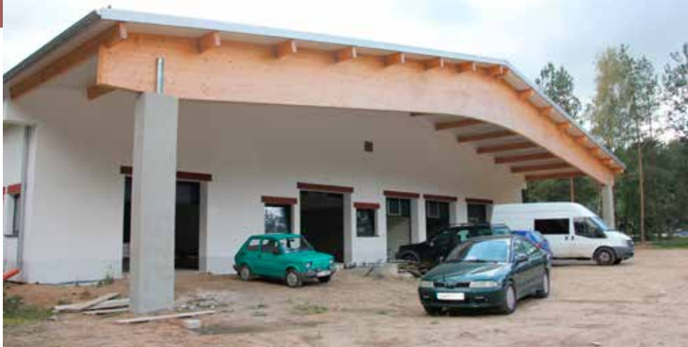
Widok na budynek od strony ptn.-zach., które pokazuje jeden z olbrzymich dźwigarów z drewna klejonego
