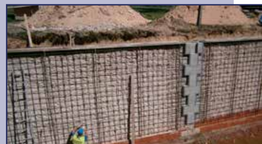
Przygotowywanie siatki zbrojeniowej przed torkretowaniem na ścianie komory śluzy
