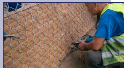
Wykonywanie ubezpieczeń w systemie „Green terramesh”
