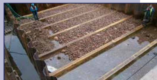
Wykonywanie narzutu kamiennego w dnie awanportu dolnego śluzy
