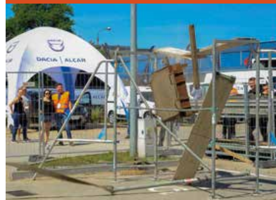
3. Przeciążenie pomostów roboczych drewnianych
