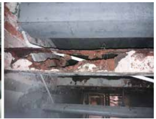
Wady stalowych belek konstrukcyjnych, podpierających sklepienie ceglane
