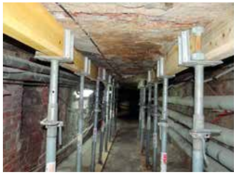
Tymczasowe wzmocnienie/podparcie stropów i sklepień zagrożonych zawaleniem
