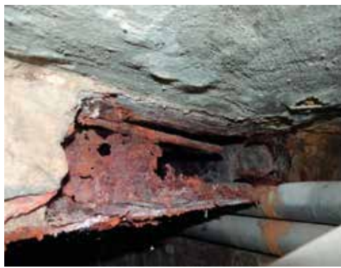
Wady stalowych belek konstrukcyjnych, podpierających sklepienie ceglane
