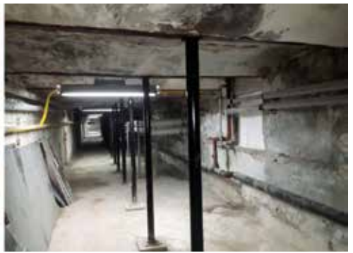
Tymczasowe wzmocnienie/podparcie stropów i sklepień zagrożonych zawaleniem
