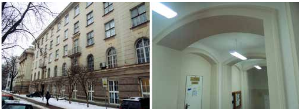
Zabytkowy budynek poddany modernizacji. Obecnie jest użytkowany zgodnie ze swoim pierwotnym przeznaczeniem, jako uniwersytecki obiekt dydaktyczno-laboratoryjny
