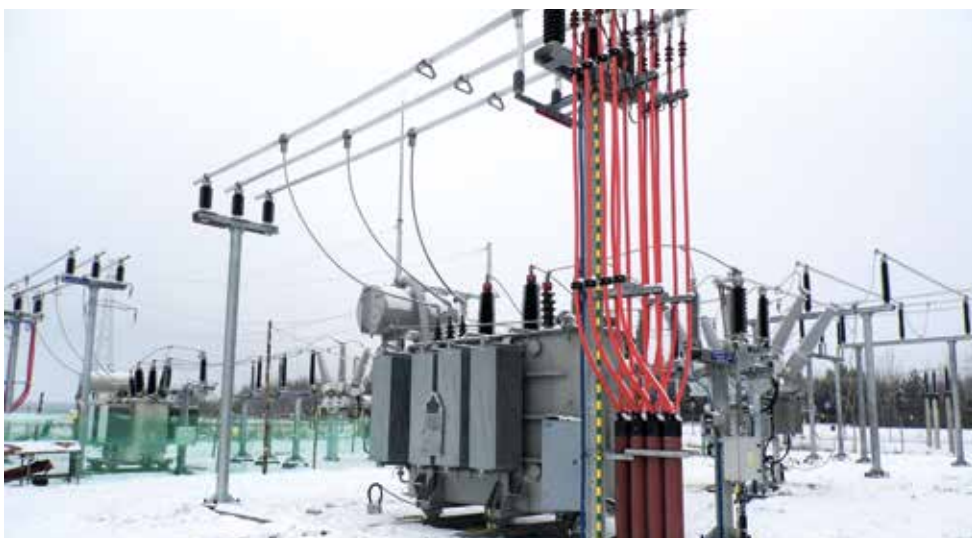
Przebudowa rozdzielni zdecydowanie polepszy pewność zasilania odbiorców przyłączonych do stacji 110/15 kV Jeżewo
