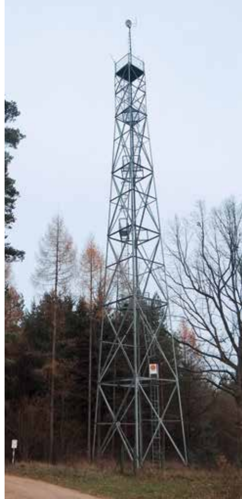
Widok przykładowej wieży obserwacyjnej o wysokości 35 m, wyposażonej w dodatkowy, 6-metrowy maszt stalowy
