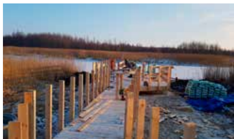
Biebrzański Park Narodowy, montaż pomostu cumowniczego, przygotowanie do betonowania bloków cumowniczych i...
