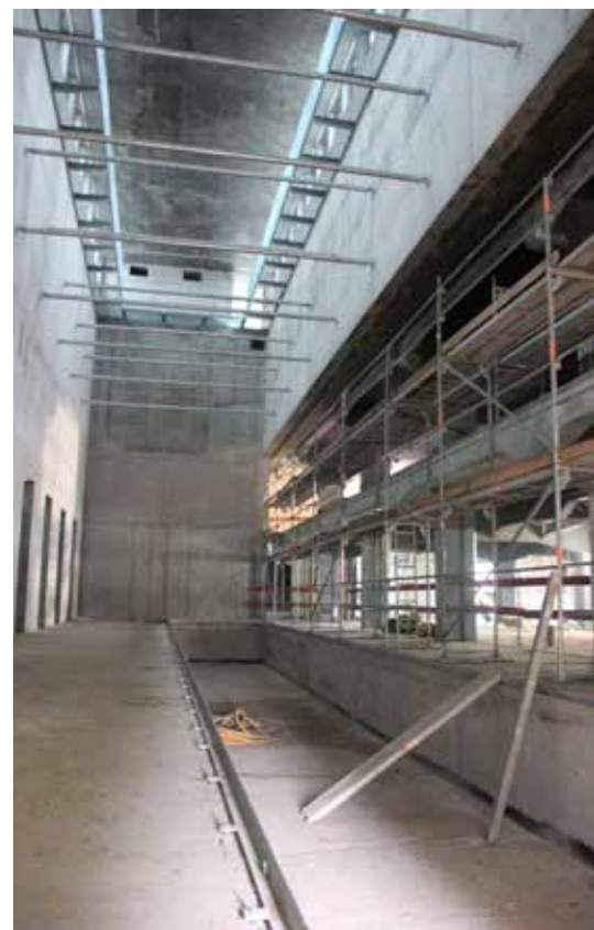
Hol główny z miejscem na tory i „gwóźdź programu”, na prawo 24-metrowy podciąg ściany
