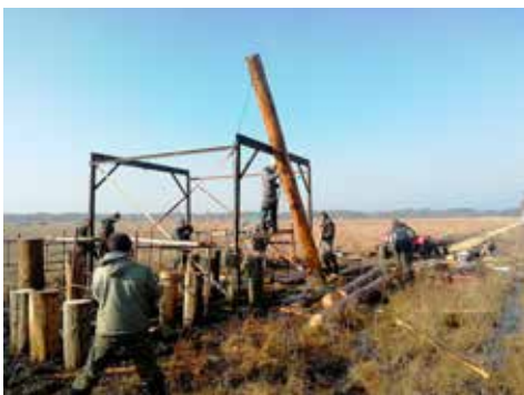
...i montaż konstrukcji wieży widokowej
