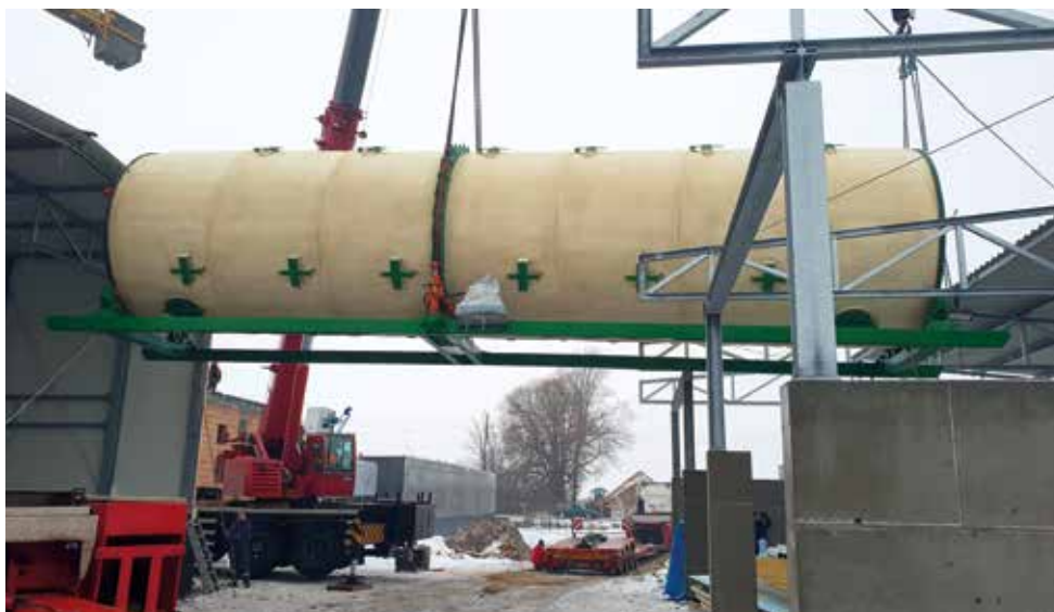
Bęben jest urządzeniem hermetycznym. Powietrze wylotowe będzie oczyszczane biofiltrem, co zapewni eliminację uciążliwości zapachowych. Na zdjęciu montaż bębna
