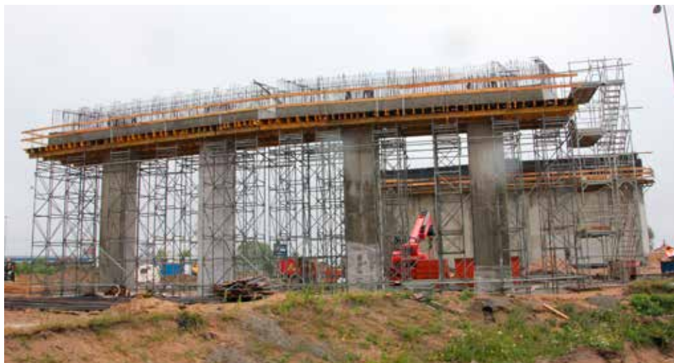
Obiekt M4 na placu budowy, stan robót z początku lipca
