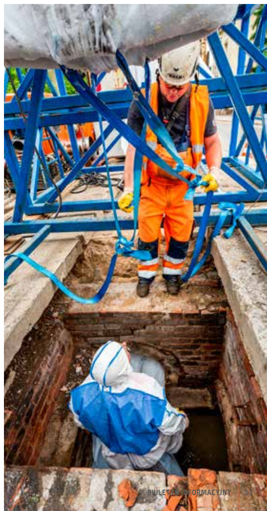
Renowację rękawem Aarsleff projektuje się indywidualnie dla każdego kanału na podstawie analizy kamerą TV
