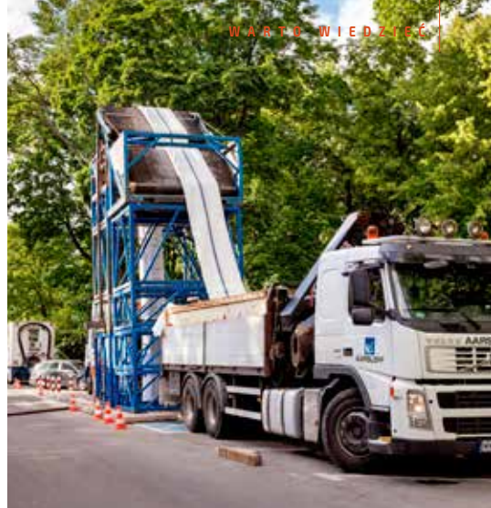
Renowację kanałów w Białymstoku przeprowadzono przy użyciu rękawa Aarsleff. Prace prowadzono z istniejących studni i komór rewizyjnych
