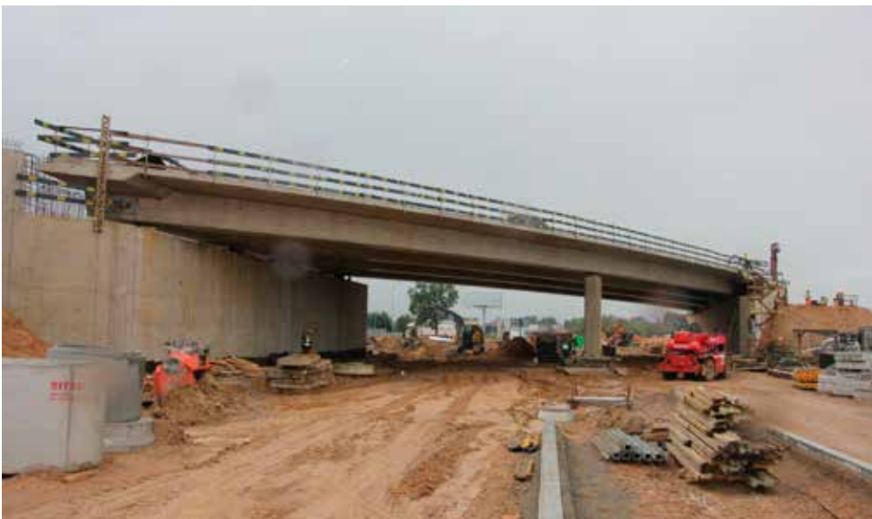
Bardzo specyficzny obiekt (M2) o kącie skrzyżowania pomiędzy osią drogi DK 8, a osią łącznic wynoszącym 29 stopni, w konstrukcji sprężonej – po cztery kable w czterech belkach
