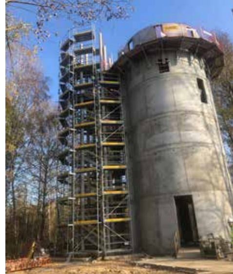
Do wieży głównego budynku obserwatorium „przyklejona” jest niezależna druga wieża, która będzie mieściła klatkę schodową z panoramiczną windą w środku. Lewe zdjęcie pokazuje (od wewnątrz wieży) deskowania kolejnej kondygnacji
