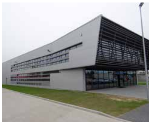
Fabryka okien i siedziba firmy Domel w Łomży – nagrodzony generalny wykonawca firma Mark-Bud Białystok
