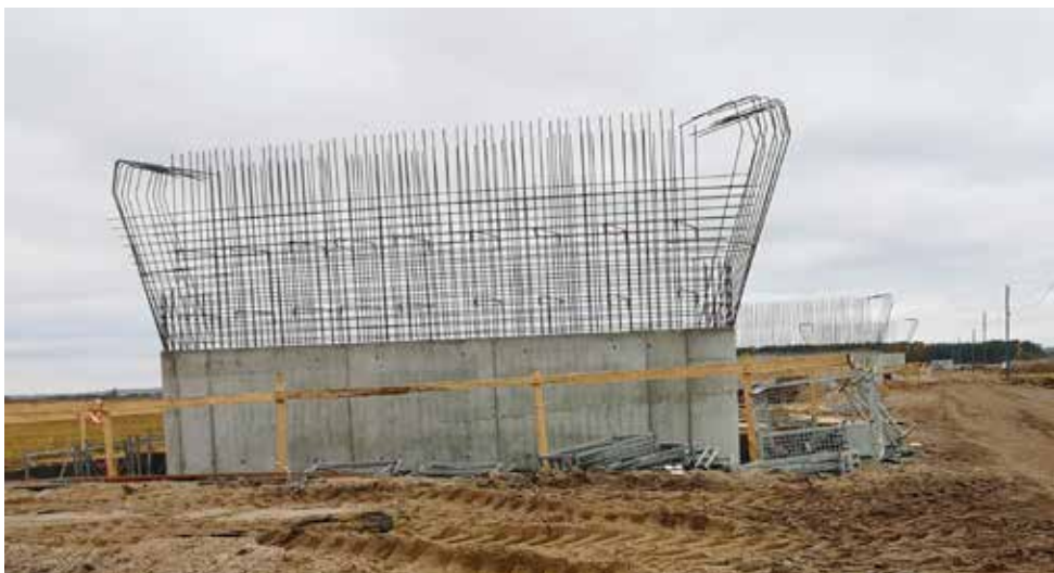
Widok na podporę – zabetonowany pierwszy etap filara
