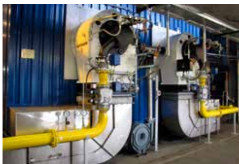
Konwersja kotła węglowego typ WR-25 na paliwo gazowe w Ciepłowni Zachód Enea Ciepło Białymstoku – nagrodzony generalny wykonawca inwestycji firma Zamer z Kraszewa
