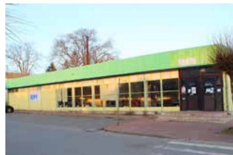
Zlikwidowany sklep spożywczy w budynku Gminnej Spółdzielni. Gmina odkupiła obiekt z działką z założeniem stworzenia tam Centrum Turystyki Kajakowej
