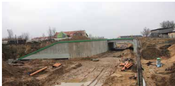
Zdjęcie muru oporowego i wykopu obrazujące jak duża jest różnica w wysokości przebiegu „starej” i „nowej” Klepackiej. Po lewej stronie widać jak docelowo będzie wyglądała powierzchnia muru
