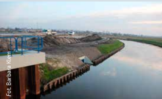
Wlot rurociągu, umożliwiającego napełnianie zbiornika. Dodam, że pierwsze „nalanie” niecki zajęło sześć dni
