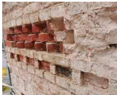
Ceglane gzymsy w dużej mierze bezmyślnie zniszczono ułatwiając sobie tym prace związane z otynkowaniem budynku
