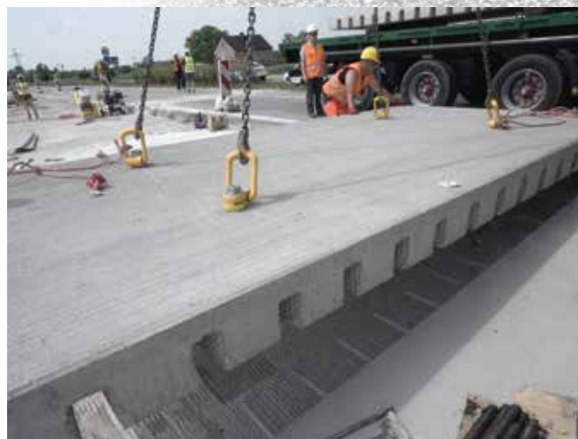
Prefabrykat w trakcie wbudowania
