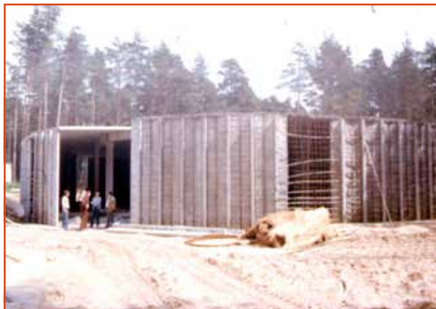
Na zdjęciach: zbiorniki na wodę żelbetowe prefabrykowane, sprzężane ciągnami stalowymi.
