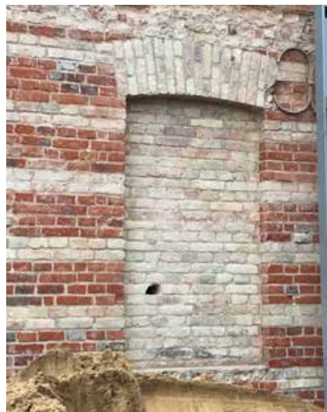
Ceglane gzymsy w dużej mierze bezmyślnie zniszczono ułatwiając sobie tym prace związane z otynkowaniem budynku
