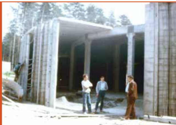
Na zdjęciach: zbiorniki na wodę żelbetowe prefabrykowane, sprzężane ciągnami stalowymi.
