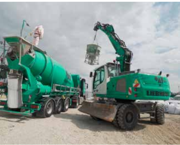
Zatadunek mobilnej wytwórni na zapleczu budowy
