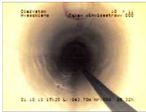
Rys. 3. Zrehabilitowany kanał sanitarny metodą CIPP
