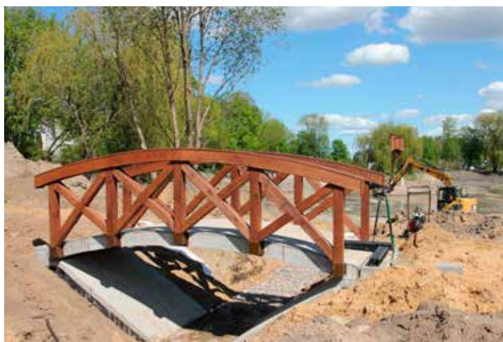
Nad rowem zbudowano żelbetonową kładkę z drewnianą balustradą
