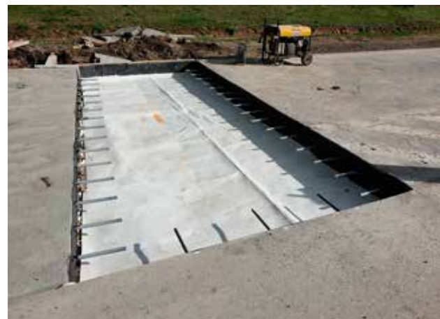
Zdjęcia pokazują prace na budowie obwodnicy Młodziyszyna. Miejsce przygotowane do odtworzenia płyty w technologii betonu szybkosprawnego
