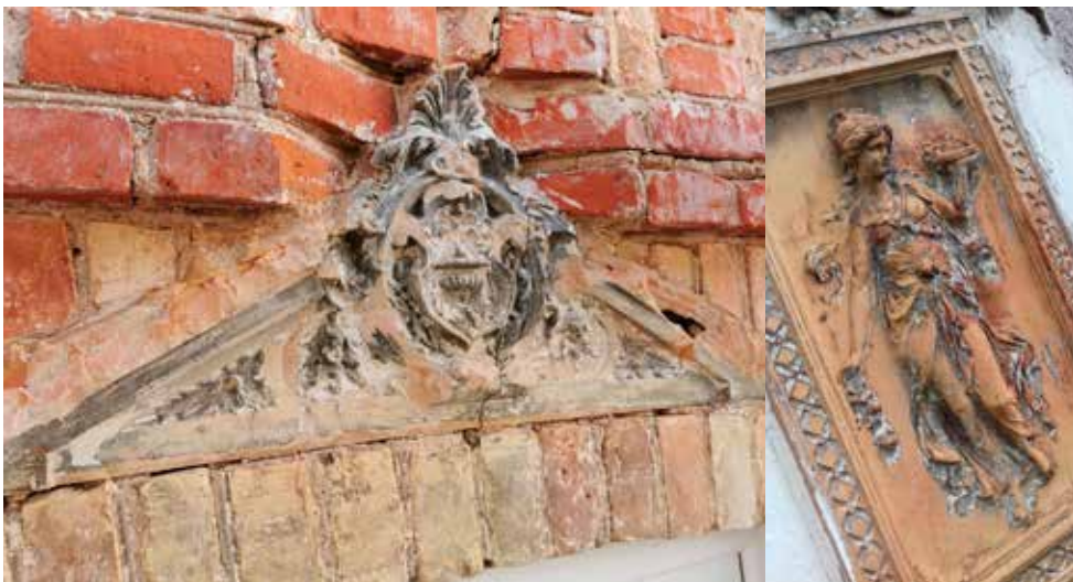
Po skuciu tynku odstąpiły się oryginalne ceramiczne ozdoby elewacji
