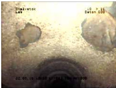
Rys. 2. Istniejący kanał sanitarny betonowy
