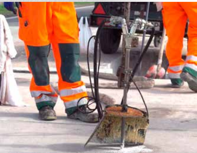
Tłoczenie geopolimeru pod płytę
