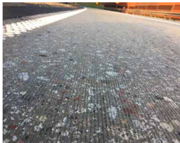
Tekstura nawierzchni po nacinaniu metodą grinding
