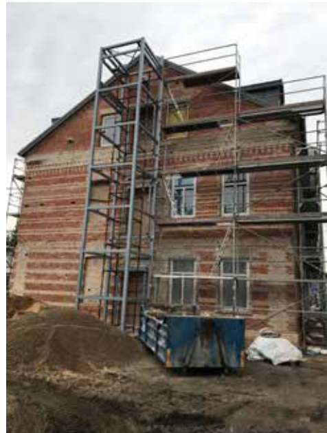
Po przebudowie obiekt zyska zewnętrzną przeszkloną windę
