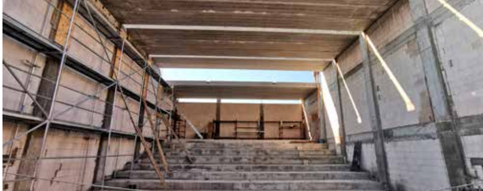
W części kinowej płyty stropowe były układane na wysokości nawet 8,5 m od poziomu posadzki, co wymagało odpowiedniego przygotowania i zabezpieczenia miejsc montażu
