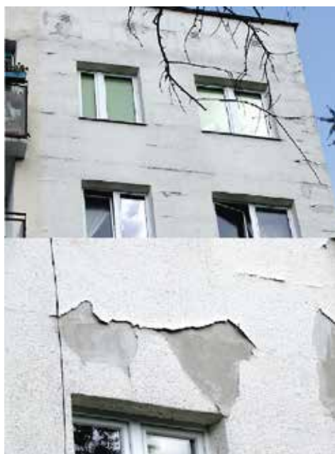
Uszkodzenia elewacji (Piotr Knyziak, 2014)
