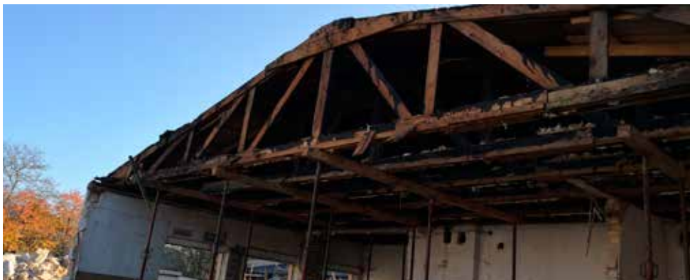
Prace rozbiórkowe należało prowadzić z dużą ostrożnością, ponieważ za ścianą – granicą rozbiórki, mieściły się użytkowane lokale. A prace trwały jesienią i zimą. Użytkowana część wymagała zabezpieczenia, na czas wzniesienia nowego
