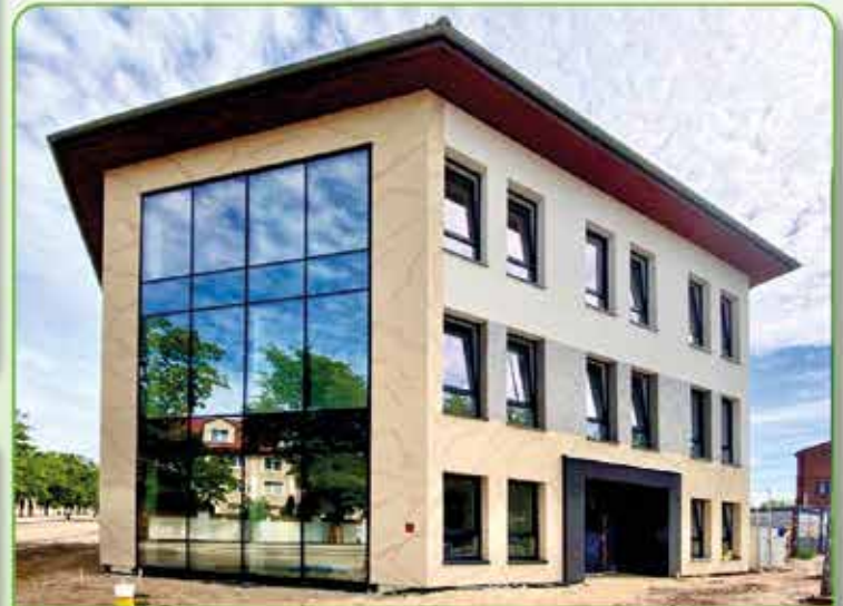
Budowa siedziby Placówki Terenowej KRUS w Łomży
