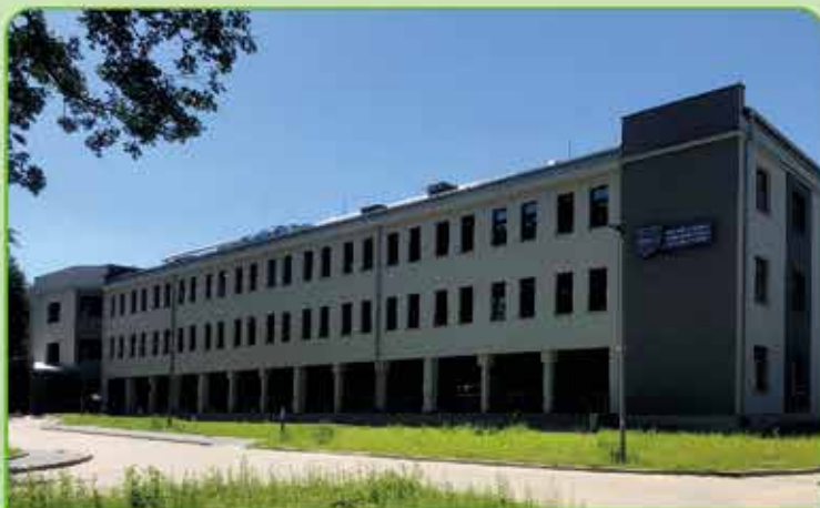
Modernizacja, remont i przebudowa Wojewódzkiego Ośrodka Profilaktyki i Terapii Uzależnień w Łomży
