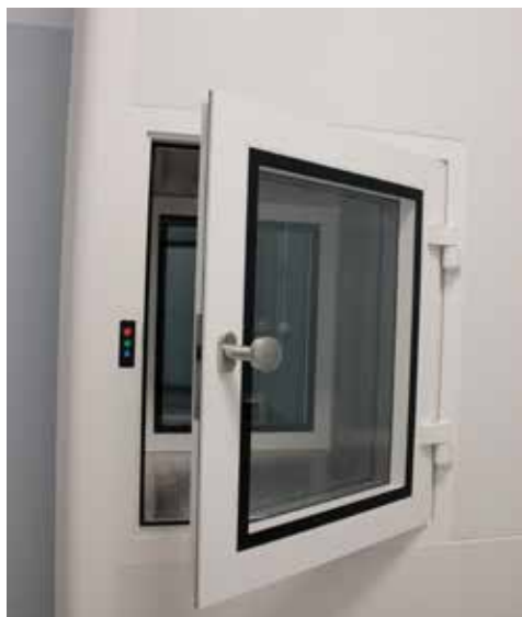
Laboratoria mikrobiologiczne od pozostałej przestrzeni laboratoriów wydzielone są śluzami
