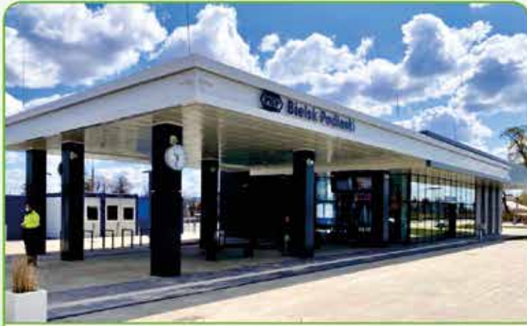
Budowa dworca kolejowego w Bielsku Podlaskim
