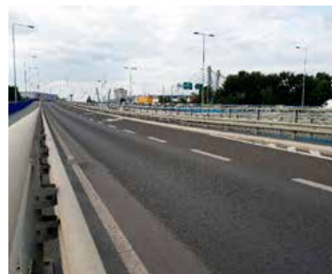
Łącznica wyjazdowa z Torunia, widok na jezdnię, ściek przykrawężnikowy z posypką z piasku kwarcowego oraz „kopertę” przy krawężnikowej kratce ściekowej
