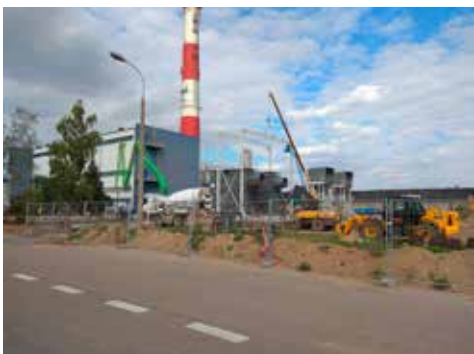
Montaż konstrukcji budynku
