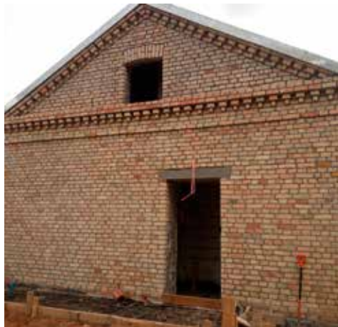
Po remoncie elewacja odzyskała blask
