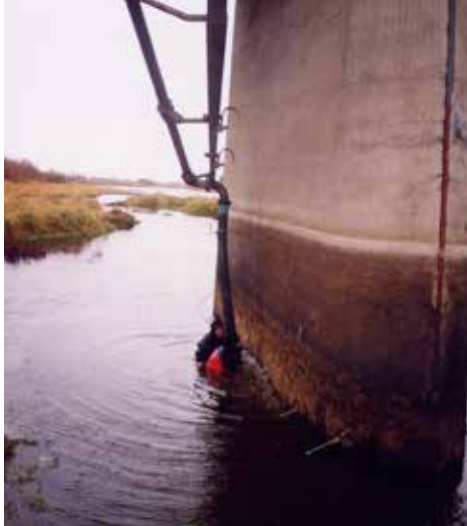
Filar mostu w Wiźnie, betonowanie
