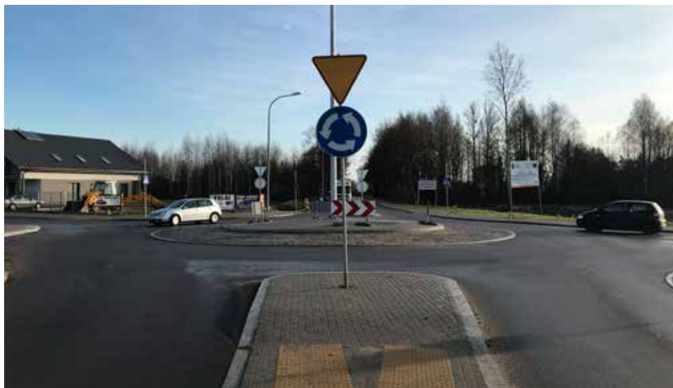
Uporządkowanie terenu inwestycji obejmowało wykonanie nasadzeń w pasach drogowych i na rondach. Na zdjęciu rondo w Sokółce
