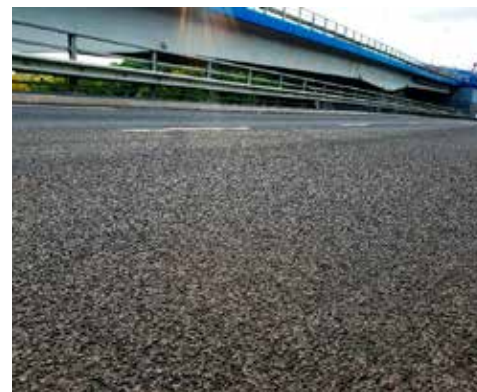
Wyjazd z tunelu, posypka z asfaltem drogowym 35/50
