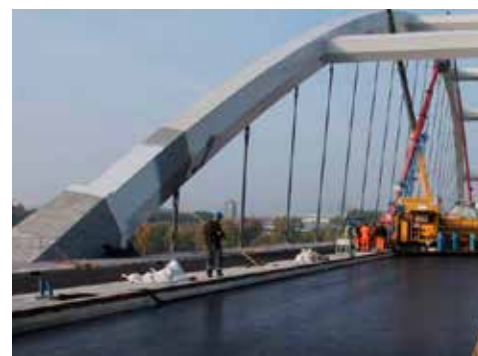
Warstwa ochronna o grubości 5 cm z MA 16 zaprojektowana wg szwajcarskich przepisów po raz pierwszy zastosowana w Polsce
