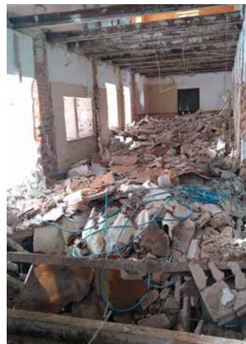
Oprócz skomplikowanych prac inżynierskich, inwestycja wymagała – zwyczajnie – sprzątnia. A nie było go mało, przykładowy urobek na zdjęciu
