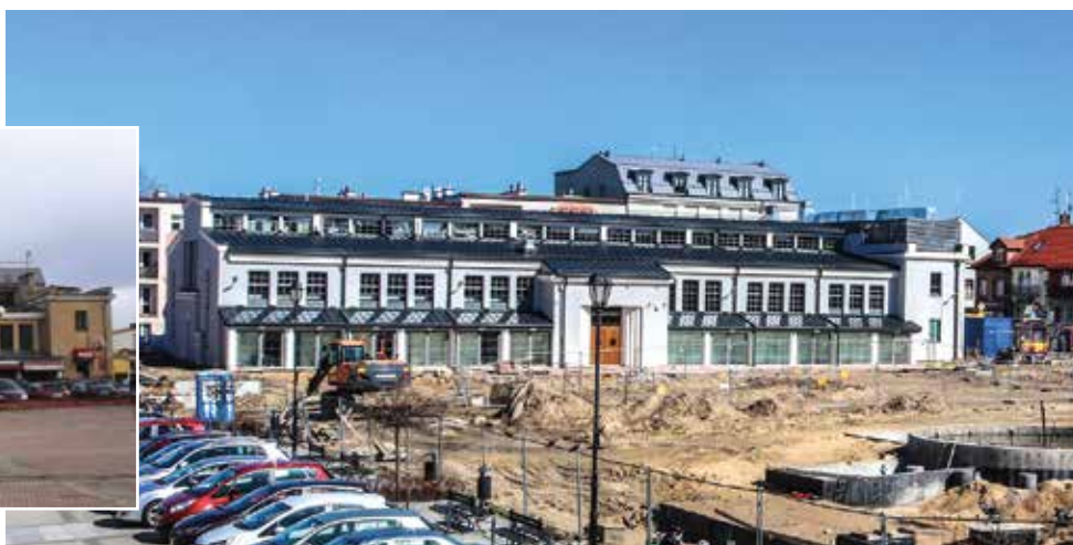
Młodszy będzie się kojarzyła już w nowej, poremontowej, odsłonie
