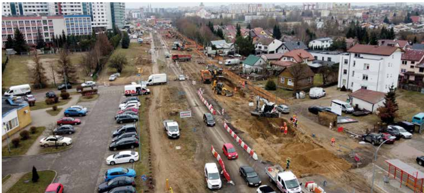
Tysiąclecia PP zyskuje rozwiązania konstrukcyjne pozwalające na poprawę płynności ruchu, zmniejszenie częstości hamowań oraz kolizyjności – wprowadzono przekrój dwujezdniowy oraz skrzyżowania skanalizowane z wydzielonymi pasami do skrętu w lewo i w prawo
