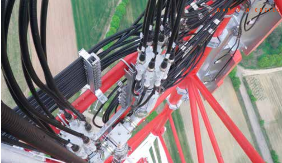
Układ rozdziatu mocy systemu antenowego
