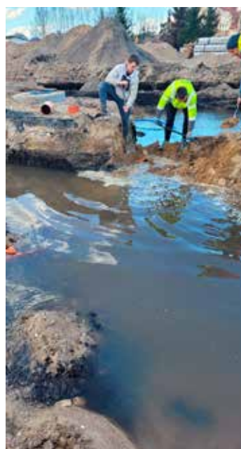
Teren był zły, a miejscami... jeszcze gorszy. Wymagał całkowitej wymiany gruntu i zastosowania co najmniej dwóch warstw mat wzmacniających
