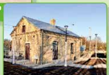
Przebudowa dworca kolejowego Jabłoń Koscielna
