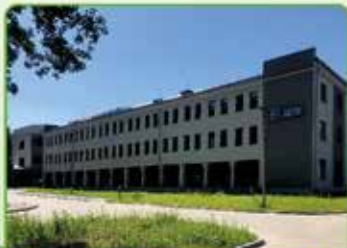
Modernizacja, remont i przebudowa Wojewódzkiego Ośrodka Profilaktyki i Terapii Uzależnień w Łomży
