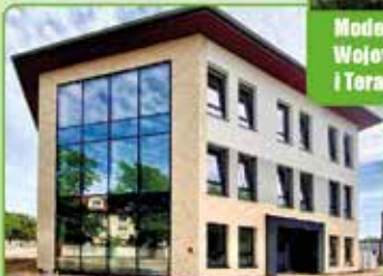
Budowa siedziby Placówki Teranowej KRUS w Łomży
