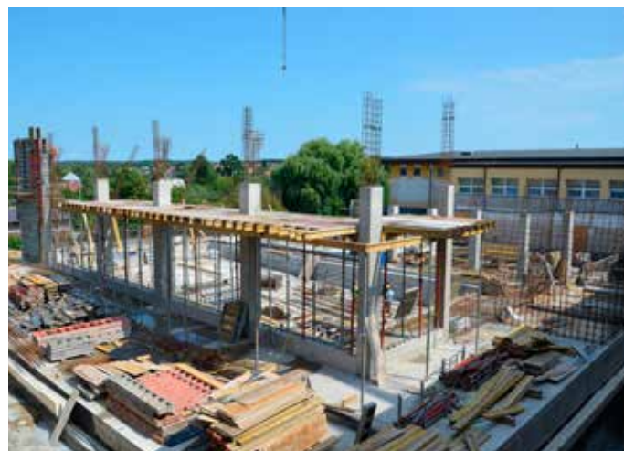
Budowa elementów parteru
