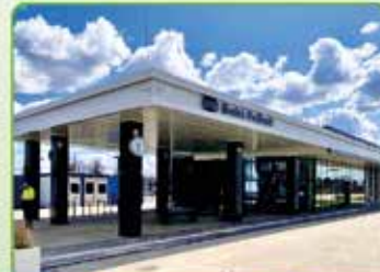
Budowa dworca kolejowego w Bielsku Podlaskim
