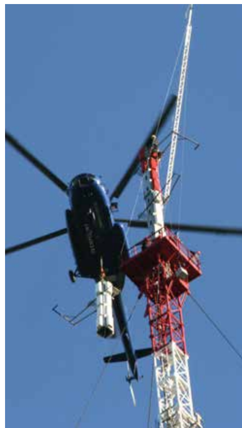
Wymiana anteny szczytowej TV z pomocą helikoptera
