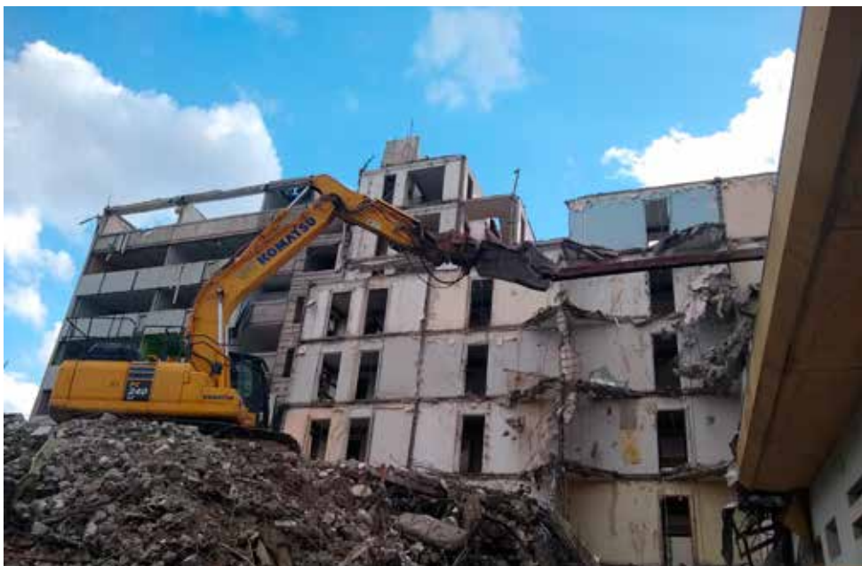
Rozbiórkę od czwartego piętra do poziomu fundamentów realizowano za pomocą koparki wyburzeniowej wyposażonej w tzw. gryzak
