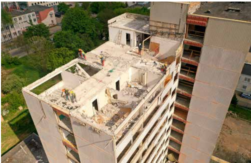
Rozbiórkę sześciu najwyższych kondygnacji części wysokiej przeprowadzono bez użycia ciężkich maszyn
