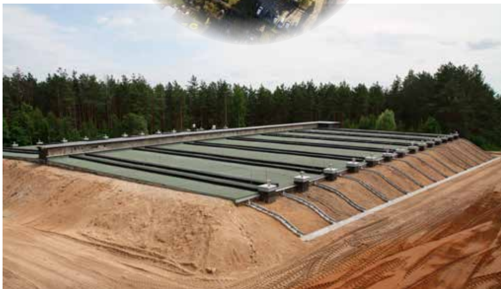
Dach nieczynnego zbiornika nie jest izolowany ziemią, tu wyraźnie widać szyny, na których zostaną zamontowane panele fotowoltaiczne
