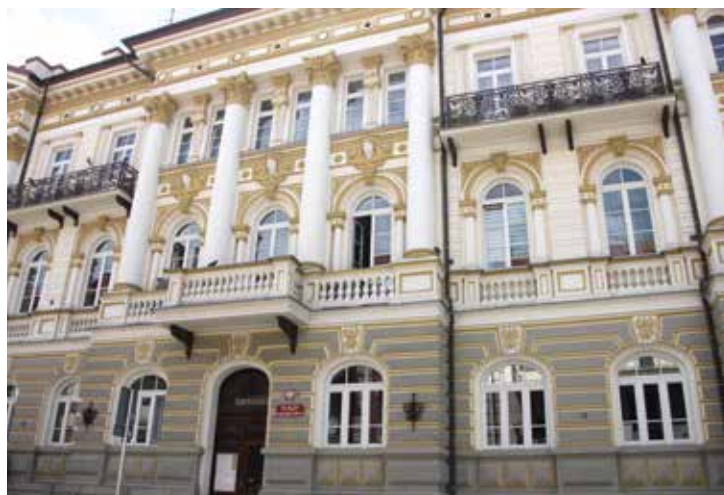
Remont zabytkowej siedziby Sądu Okręgowego w Łomży, to też praca Andrzeja Wszeborowskiego.
