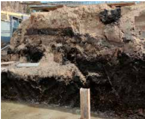
Grunt słabonośny w wykopie oraz na przekroju geologicznym.
