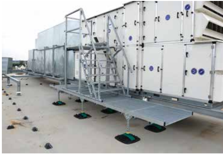
Podest dostępowy z górnym elementem ruchomym
