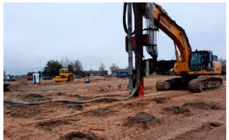
Wzmocnienie podłoża pod konstrukcję oraz posadzkę hali w Augustowie.
