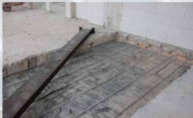
Stropy na każdym piętrze musiały mieć wykonane otwory na nowe szachty wentylacyjne
