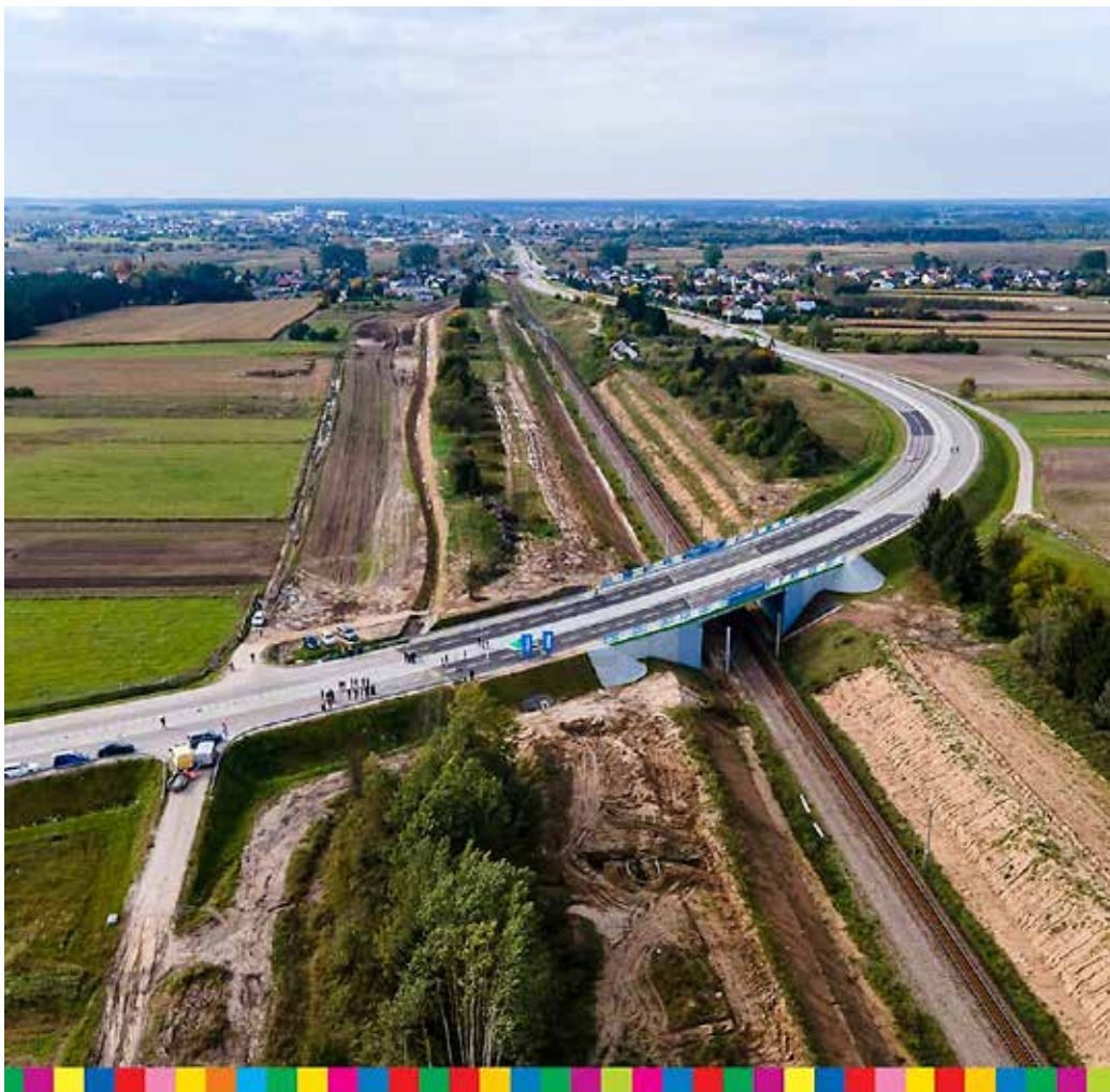
Nowy wiadukt w Uhowie to pierwsze z 25 skrzyżowań dwupoziomowych, które zostaną wybudowane między Białymstokiem i Czyżewem dzięki modernizacji linii Rail Baltica
