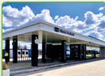
Budowa dworca kolejowego w Bielsku Podlaskim
