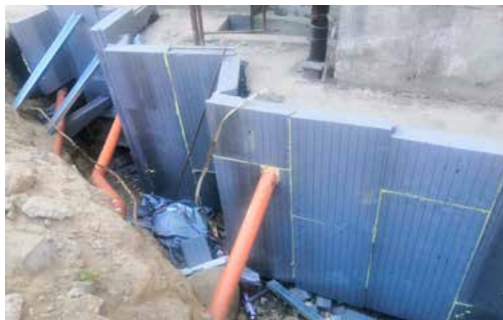
Na zewnątrz cokół budynku obłożony był starymi płytami z piaskowca o gr. 8cm. Po zdjęciu płyt granitowych z chodników i wykonaniu hydroizolacji te same płyty z piaskowca musiały wrócić na miejsce z dodatkowym okapnikiem zewnętrznym
