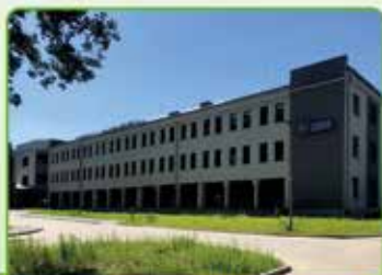
Modernizacja, remont i przebudowa Wojewódzkiego Ośrodka Profilaktyki i Terapii Uzależnień w Tomży
