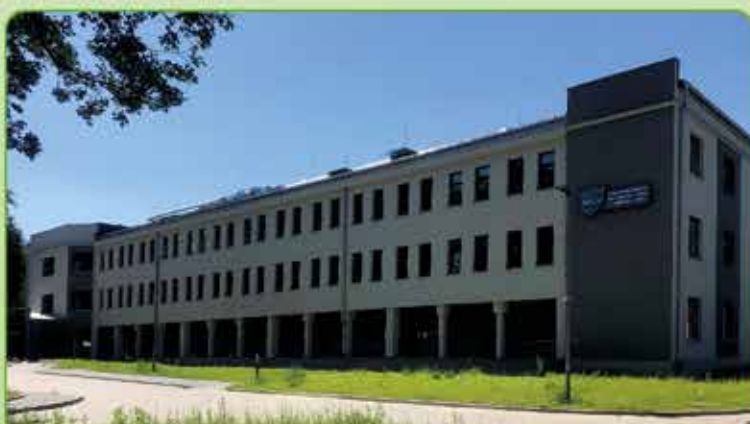
Modernizacja, remont i przebudowa Wojewódzkiego Ośrodka Profilaktyki i Terapii Uzależnień w Łomży
