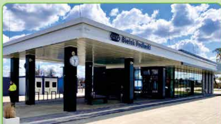
Budowa dworca kolejowego w Bielsku Podlaskim
