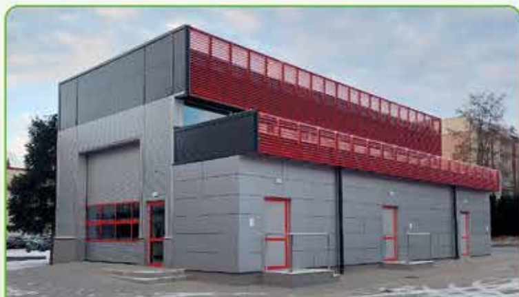
Myjnia przejazdowa samochodów pożarniczych w Komendzie Miejskiej PSP W Białymstoku
