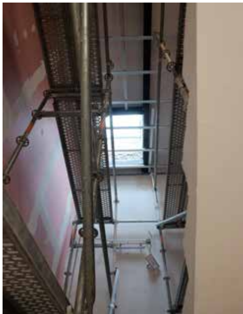
Widok klatek schodowych w trakcie prac i wizualizacja nowej
