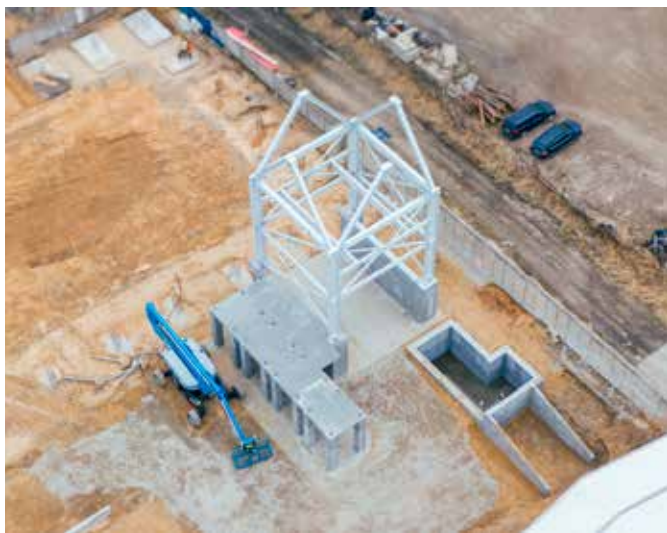
Betoniarnia stanie tuż obok hali, by skrócić drogę mieszanki betonowej do stanowisk produkcyjnych
