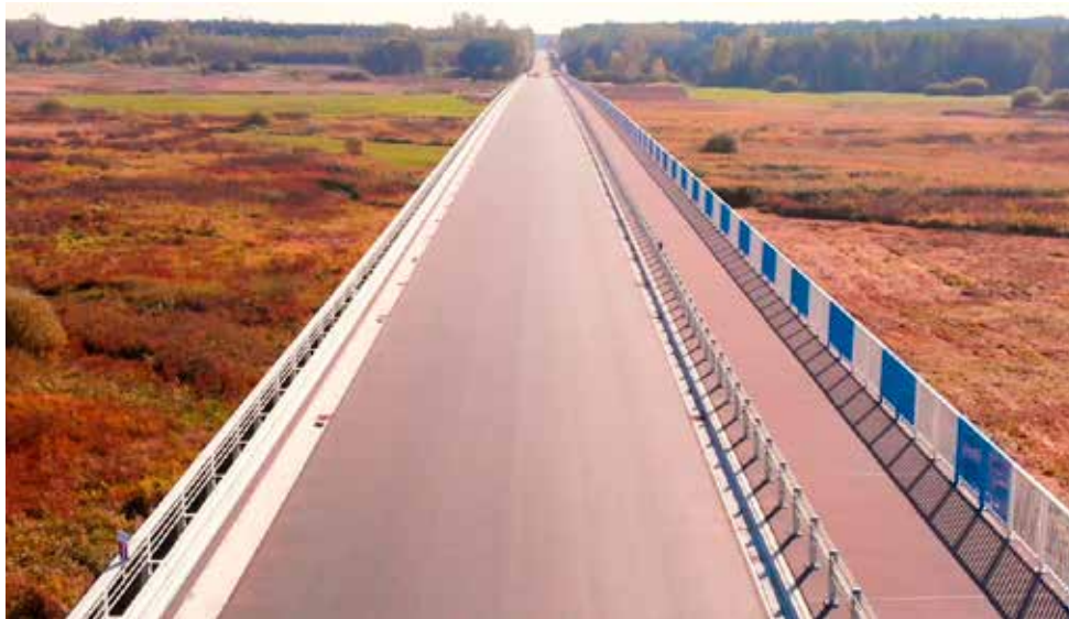
1 kwietnia br. estakada (wraz z obwodnicą Narwi) została otwarta do ruchu publicznego
