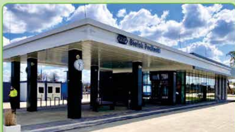
Budowa dworca kolejowego w Bielsku Podlaskim
