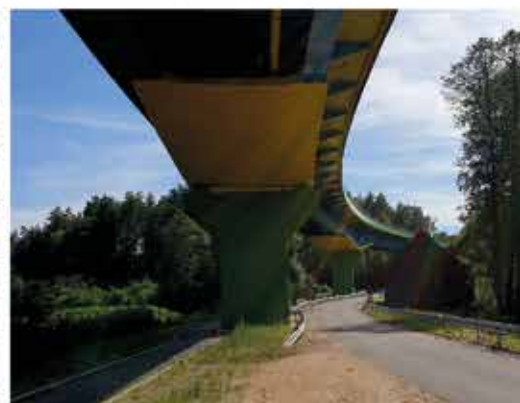
Estakada w ciągu DW676 w m. Krasne
