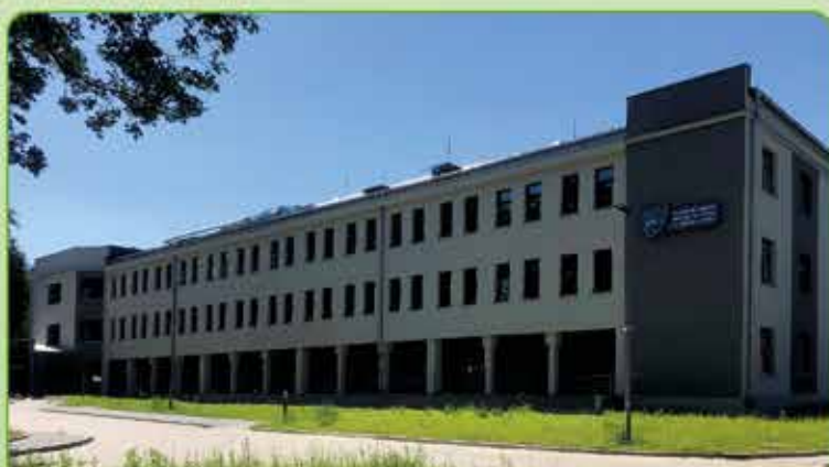
Modernizacja, remont i przebudowa Wojewódzkiego Ośrodka Profilaktyki i Terapii Uzależnień w Tomz
