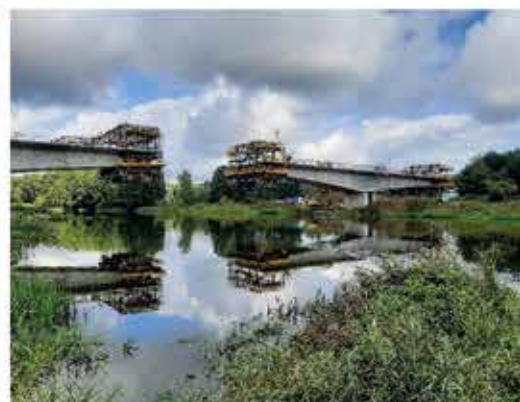
Most przez rzekę Wartę w ciągu obwodnicy m. Wronki
