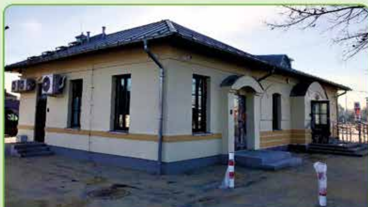
Przebudowa dworca kolejowego w Szepietowie
