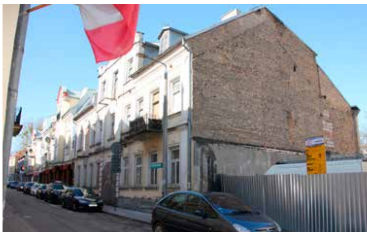
Po remoncie w budynku znajdzie się dziesięć lokali użytkowych. Pozostawiona będzie strefa wejściowa w formie przejścia bramowego, zamykanego kratami, na osi frontowej od ulicy
