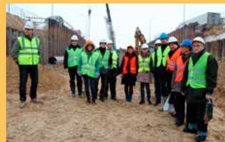
Wycieczka techniczna na budowę tunelu, ul. Andersa w Białymstoku, 28.02.2013 r.
