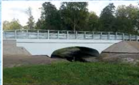
Przebudowa mostu na rzece Kukawka
