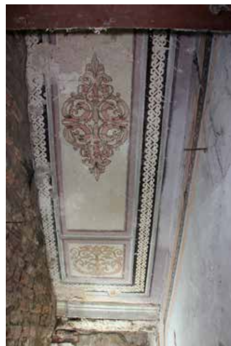
Projekt zakłada możliwie najmniejszą ingerencję w substancję zabytkową – demontaż i remont oryginalnych elementów, następnie ich ponowne wmontowanie w obiekt. Na zdjęciu jedna z najlepiej zachowanych polichromii
