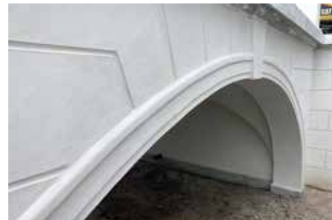
Każde z czterech przęseł mostu to sklepienia łukowe, jakie spotykamy np. w kościołach. Do tynkowania wcale „przyjazne” nie są (uśmiech)
