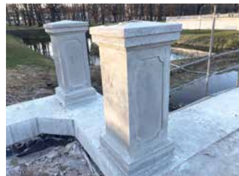
Gzymsy są żelbetowe, wylewane na budowie w szalunkach od razu w kształcie gzymsów. Podobnie powstawały słupki pod barierki na moście
