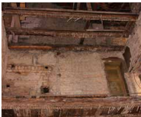
Klatka schodowa, stropy i więźba dachowa są drewniane
