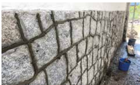
Masywne filary mostu (jak się okazało w trakcie prac, puste w środku) zostały odrestaurowane z zewnątrz, zyskały nowotylnki okładzinę kamienną na ścianach żelbetowych
