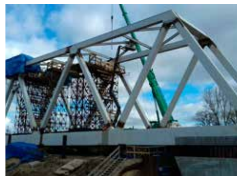
Montaż stężeń i wiatrownic
