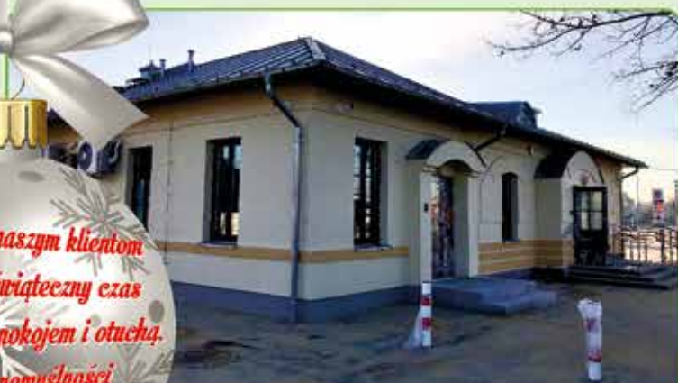
Przebudowa dworca kolejowego w Szepietowie
