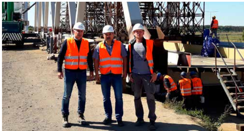
Na upalnym jeszcze placu budowy (od lewej): Krzysztof Pietras – dyrektor Regionu Centralnego Realizacji Inwestycji PKP PLK SA, Janusz Rutkowski – kierownik budowy i Rafał Garncarek – kierownik robót mostowych
