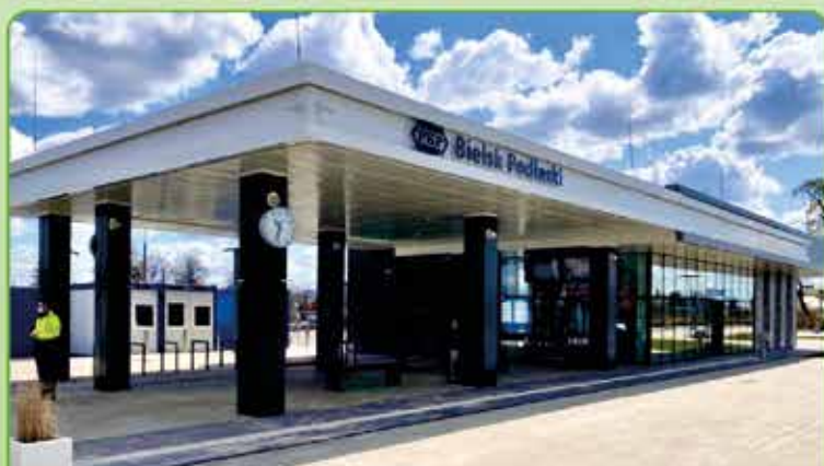
Budowa dworca kolejowego w Bielsku Podlaskim
