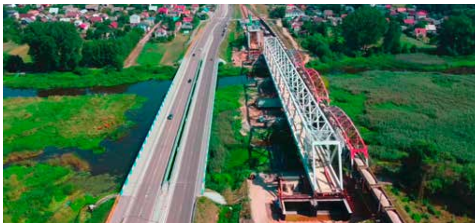
Widok po nasunięciu poprzecznym w tor nr 1
