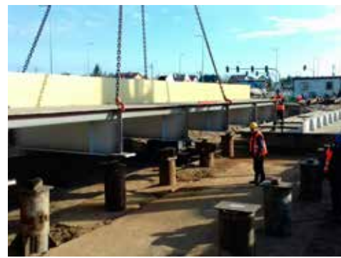
Montaż płyty ustroju
