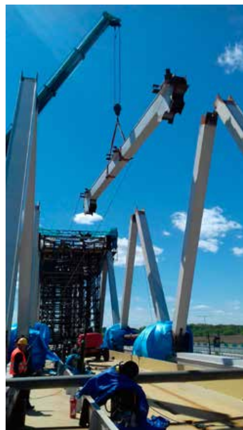
Montaż górnej belki
