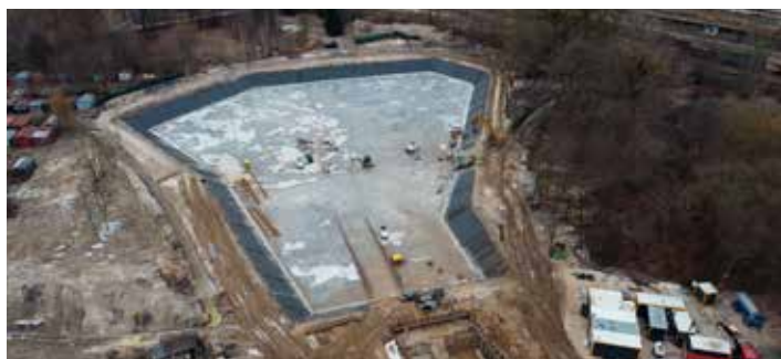
Po drodze mijamy budowę zbiornika retencyjnego
