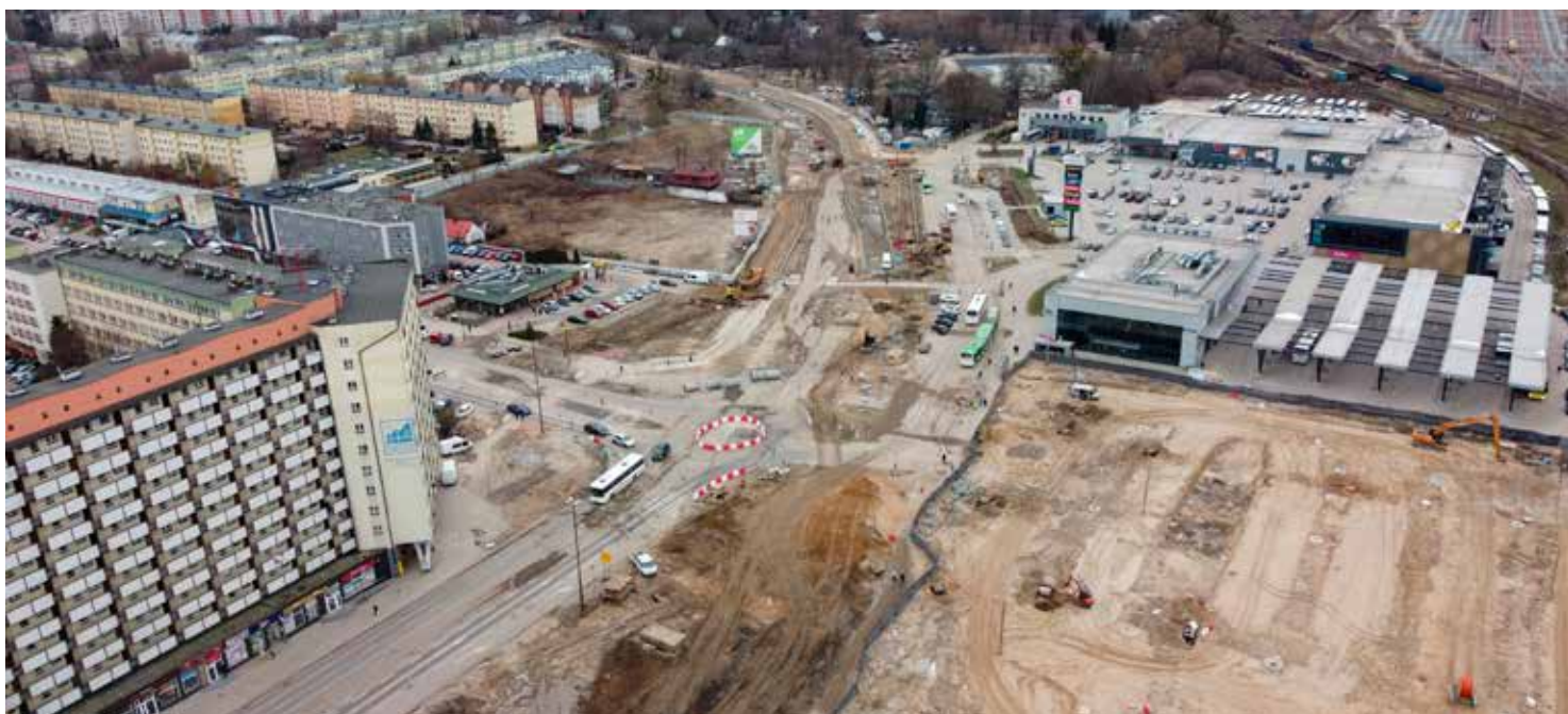
Kanalizacja na skrzyżowaniu z ul. Wyszyńskiego była układana na głębokości 5-6 m. Wykonawcy „przechodzili” otwartym wykopem w szalunkach przy czynnym ruchu i sygnalizacji świetlnej. Deszczowa pora jesienno-zimowa i do zamontowania żelbetowe rury \varnothing 1.600 . I lecimy nad budową, start w okolicy dworca PKS
