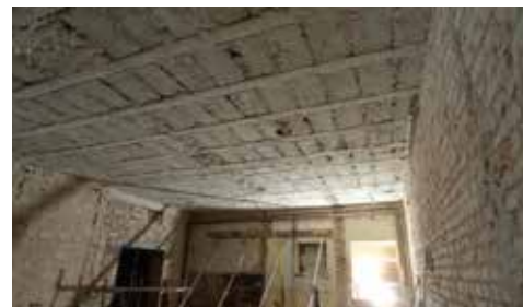
Strop przed wzmacnieniem
