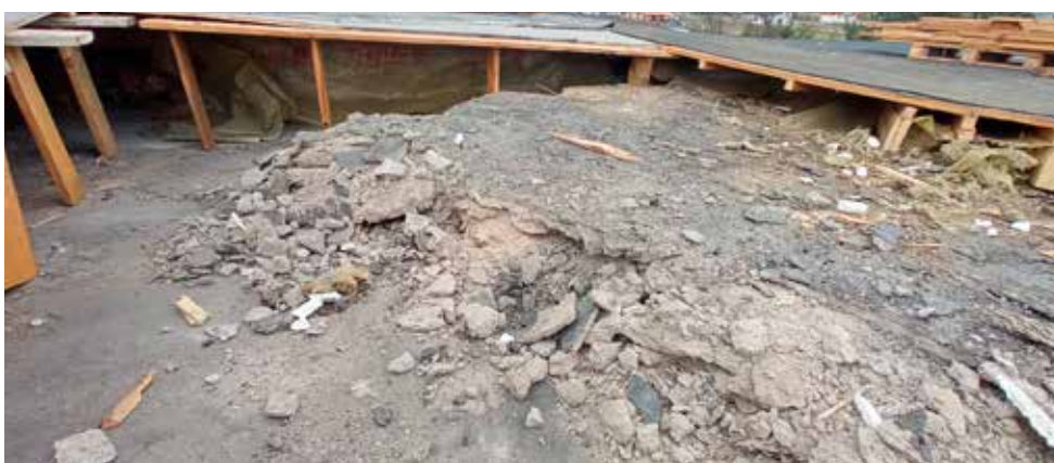
Warstwy do usunięcia na dachu
