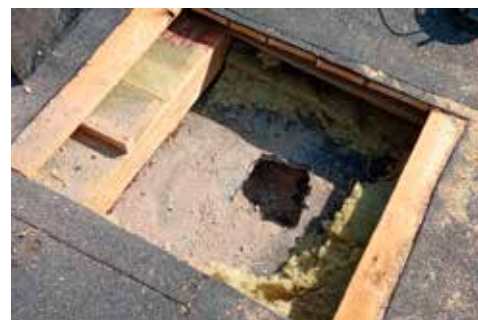
Odkrywka w dachu
