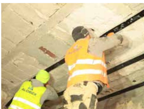
Klejenie taśm węglowych FRP
