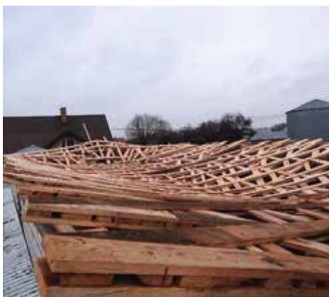
Niezamocowane do murów dźwigary runęły jak kostki domina. Na zdjęciach zniszczone dźwigary drewniane: a) widoczny brak elementów łączących dźwigary ze ścianami, b) zawalona ściana szczytowa
