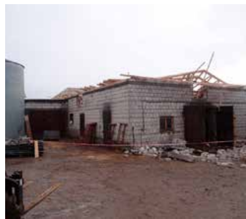
Niezamocowane do murów dźwigary runęły jak kostki domina. Na zdjęciach zniszczone dźwigary drewniane: a) widoczny brak elementów łączących dźwigary ze ścianami, b) zawalona ściana szczytowa
