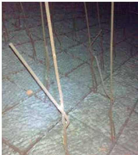
Pochyły sufit podwieszany nad audytorium: a) widok stropu, b) ruszt z prętów zbrojeniowych podwieszonych za pomocą cięgien do stropu
