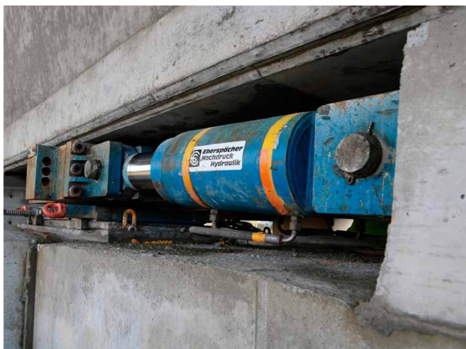
Sekwencja wysuwania mostu realizowana jest za pomocą hydraulicznego urządzenia firmy Eberspächer
