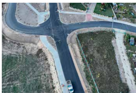
Skrzyżowanie obwodnicy z ul. Kolejową w Sokolach
