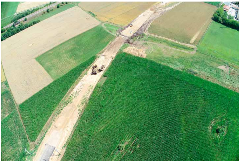
Dzięki właściwej organizacji pracy wymianę ok. 10 tys. m 3 wykonano w lekko ponad trzy tygodnie. Na zdjęciu problematyczny odcinek trasy
