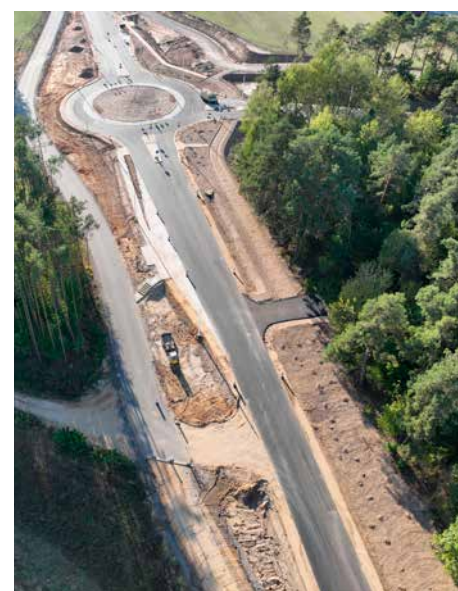
Rondo – wyjazd w stronę Wysokiego Mazowieckiego, km 40+275
