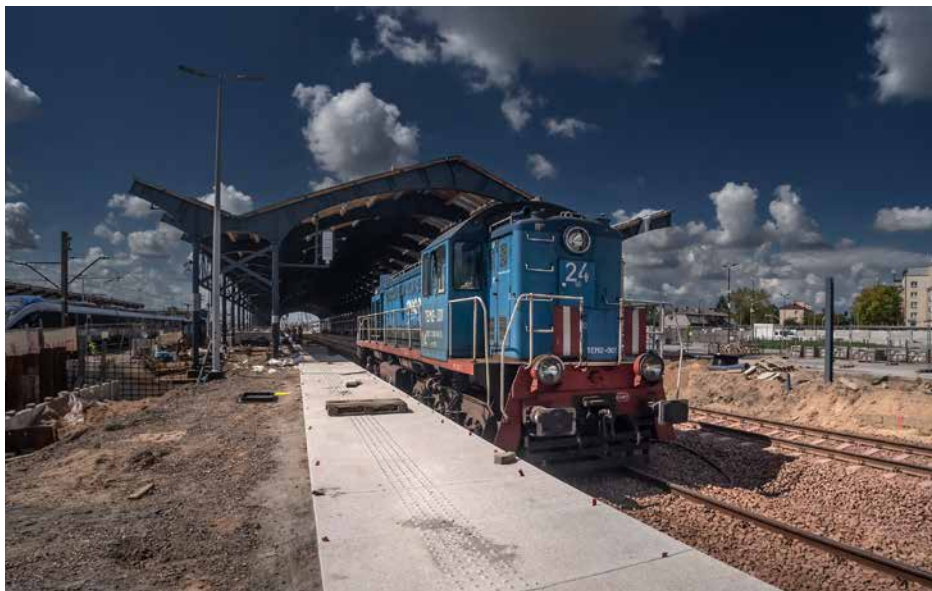
Próbne obciążenie tunelu taborem kolejowym. Wytrzymał, uff... (uśmiech)
